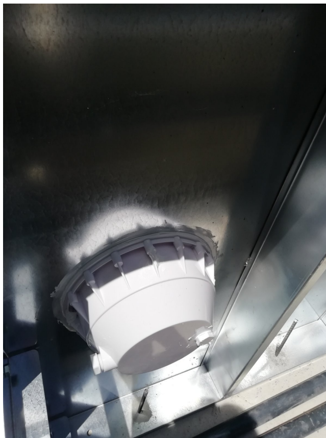
Σχήμα 8.4 Το σώμα του υποβρύχιου φωτιστικού, όπως φαίνεται πίσω από το πάνελ.
