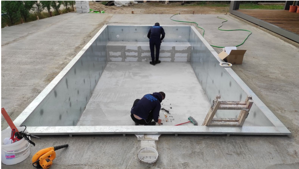
Σχήμα 10.1 Έτοιμα παραδίνεις την πισίνα στον συνεργάτη: καθαρός και στεγνός πυθμένας, σκουπισμένες γωνίες, τίποτα πεταμένο μέσα.
