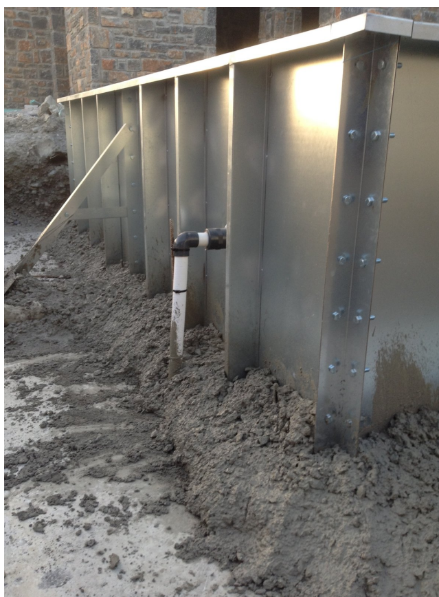
Σχήμα 9.2 Φρέσκο περιμετρικό μπετό στη βάση των πάνελ, από έξω. Δεν χρειάζεται καλούπι: τα πάνελ και το πρανές κάνουν τη δουλειά του.
