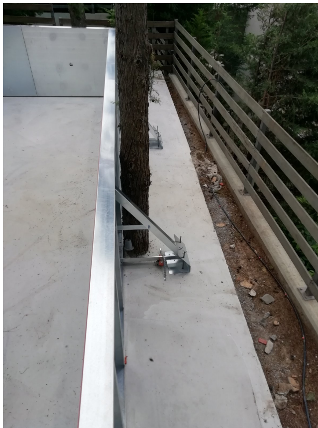
Σχήμα 7.5 Η αντηρίδα από την πίσω πλευρά: η διαγώνια δοκός πιάνει ψηλά στο πάνελ και η βάση της πατά στην πλάκα.
