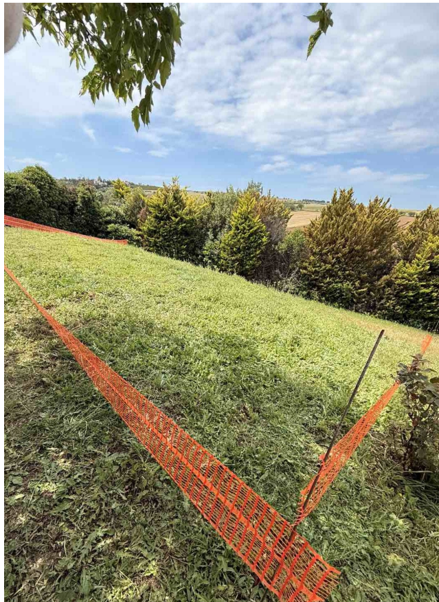
Σχήμα 5.1 Τα όρια του λάκκου σηματοδομένα στο γρασίδι πριν έρθει το μηχάνημα. Εδώ με πορτοκαλί πλέγμα· εσύ μπορείς με πασσάλους, σπάγκο και σπρέι.
