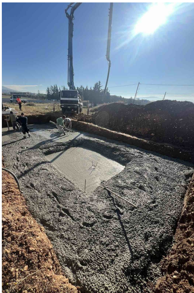
Σχήμα 6.2 Η μέρα της σκυροδέτησης: η αντλία ρίχνει μπετό και το συνεργείο το απλώνει και το ισιώνει.
