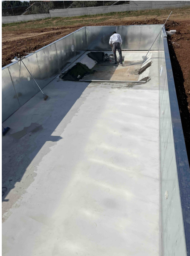
Σχήμα 6.4 Λείανση με κόλλα πλακιδίου: ο πυθμένας γίνεται λείος και επίπεδος, για να «κάτσει» σωστά η μεμβράνη.
