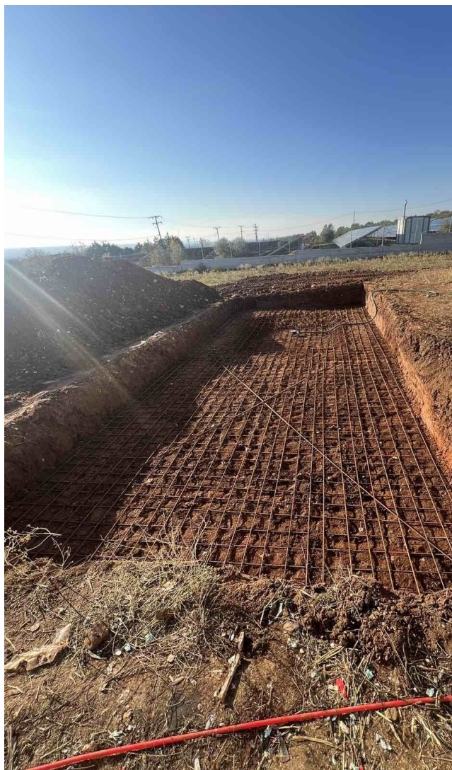
Σχήμα 6.1 Ο οπλισμός (σιδερένιο πλέγμα) απλωμένος σε όλο τον πυθμένα του λάκκου, πριν ρίξουμε μπετό.
