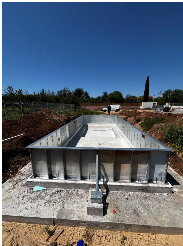
Σχήμα 7.7 Το «κέλυφος» στο τέλος του κεφαλαίου: όλα τα πάνελ όρθια, αλφαδιασμένα, με τις αντηρίδες στη θέση τους πάνω στην πλάκα.
