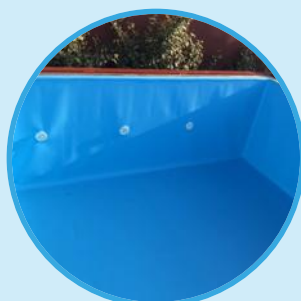
Liner de PVC cortado a medida
