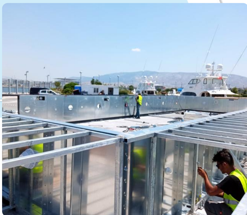
Piscina dove non si può scavare: sottostruttura in acciaio, pannelli, liner e deck sul molo di una marina ad Atene.
