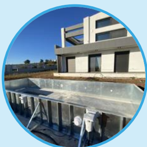
Pannelli in acciaio con contrafforti e fissaggi
