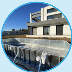
Panouri de oțel cu contraforți și prinderi
